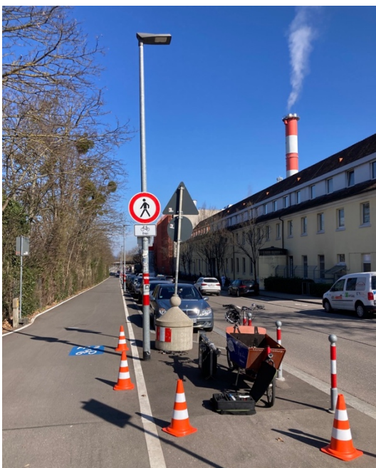
Abbildung 5: Maßnahmen zur Arbeits- und Verkehrssicherheit während der Montage (eigenes Fotoarchiv)
